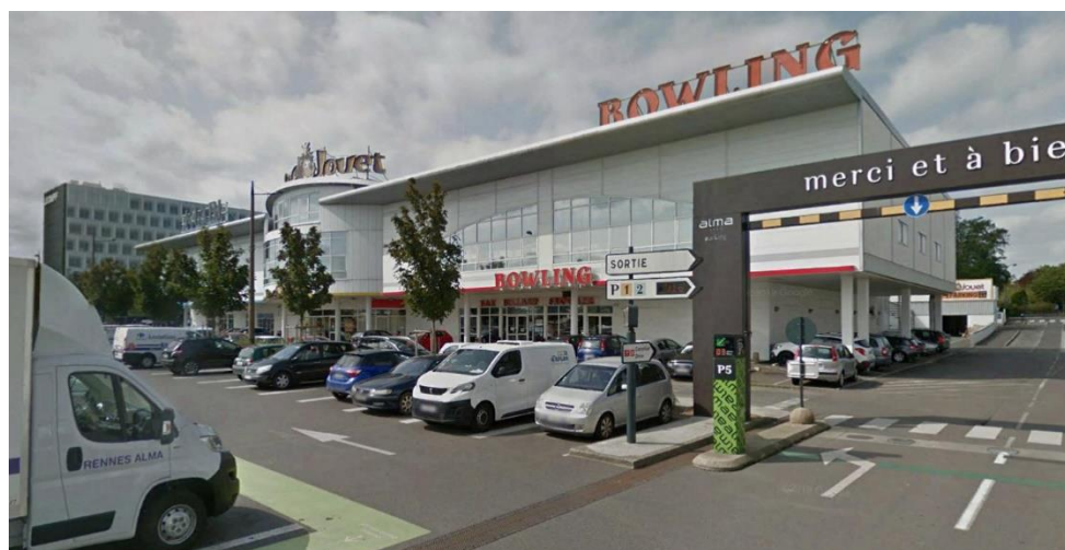
VUE MONTRANT LA FACADE PRINCIPALE EST :
